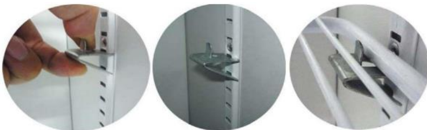
Рис. 8. Встановлення кронштейнів полиць.
